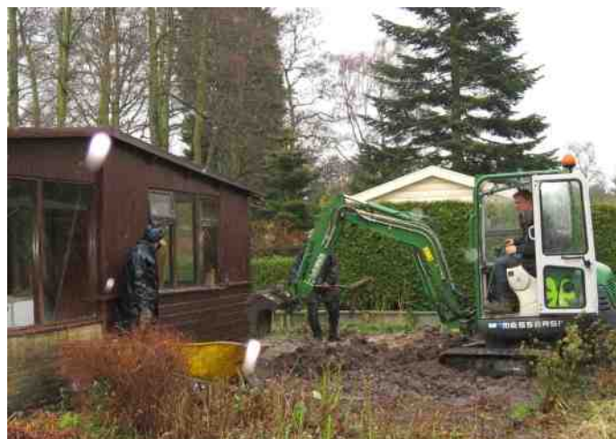
Het huisje wordt afgebroken
